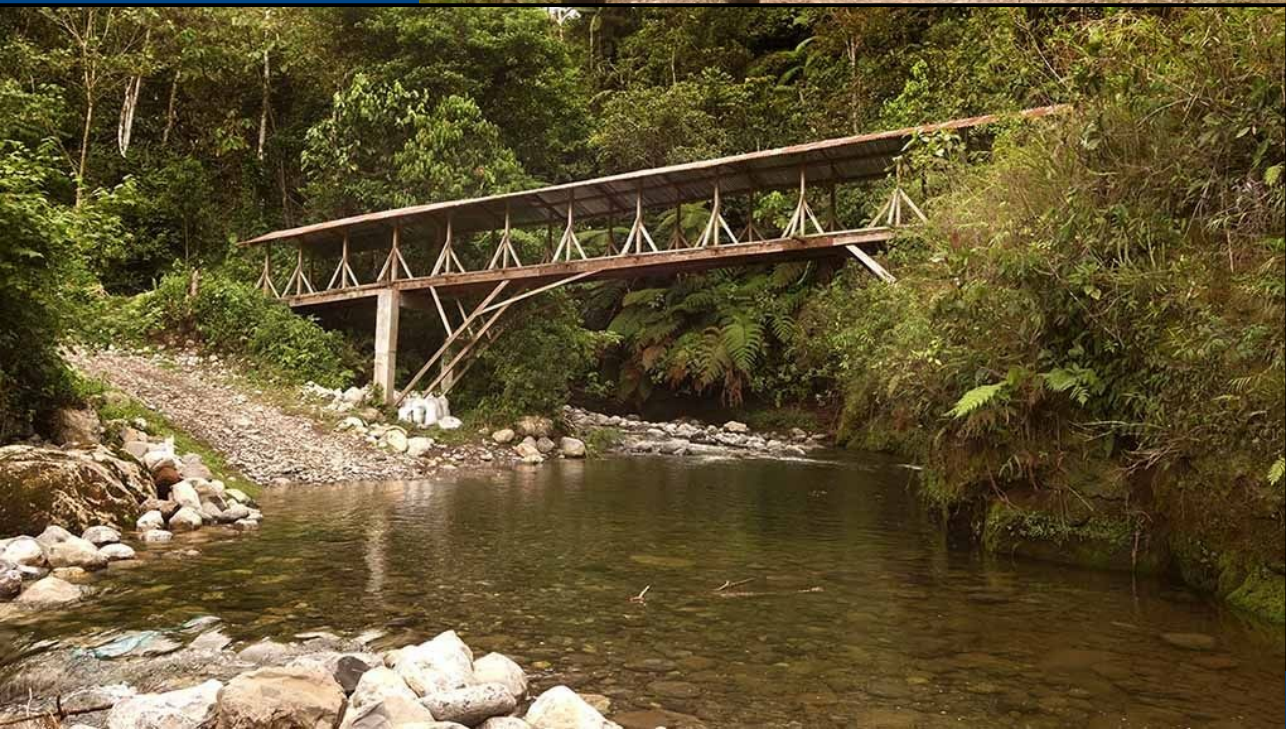
Puente sobre el Rio Salas.
