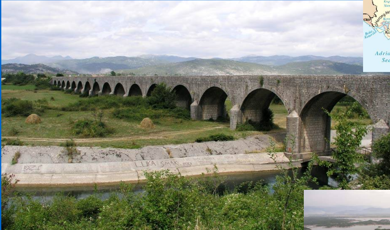
Carev Most : le pont du Tsar.
