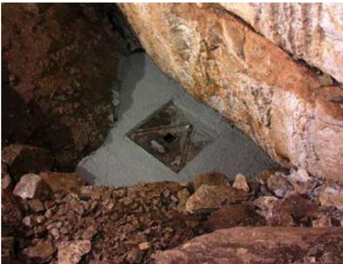
**Fig. 6 : La dalle coulée, la porte installée.**
