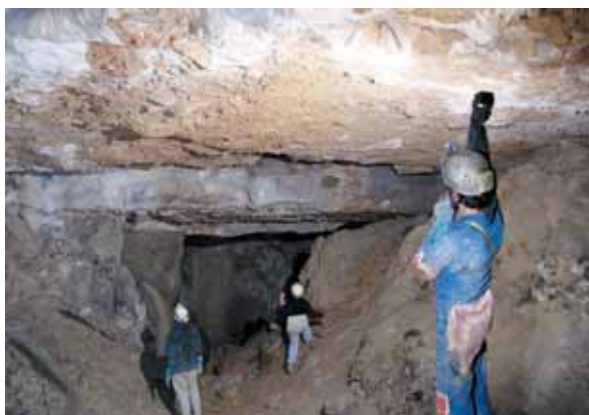
Figure 8 - Galerie principale du trou Madame creusée dans les marnes et une partie du conglomérat. Le toit plat correspond à la base des conglomérats (photo. J.-Y. BIGOT). Main gallery of the Trou Madame that develops into marls and partly into conglomerate. The planar ceiling corresponds to the base of the conglomerate.
