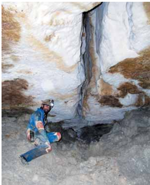
Figure 9 - Érosion des marnes au droit d'une fracture dans les calcaires nummulitiques du trou Madame (photo. J.-Y. BIGOT). Erosion of the marls below a fracture in the limestone ceiling. Trou Madame.
