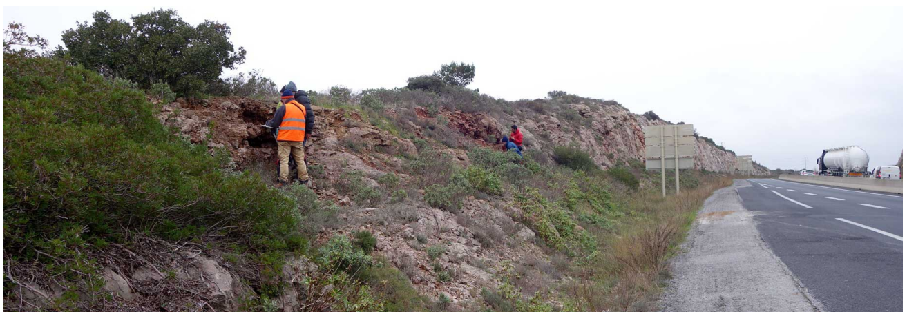
Figure 7. La tranchée de la départementale 600 reliant Balaruc à Sète.
