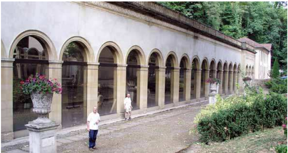
Figure 8 : Le bâtiment classé des thermes Fraxine à Ussat-les-Bains.
