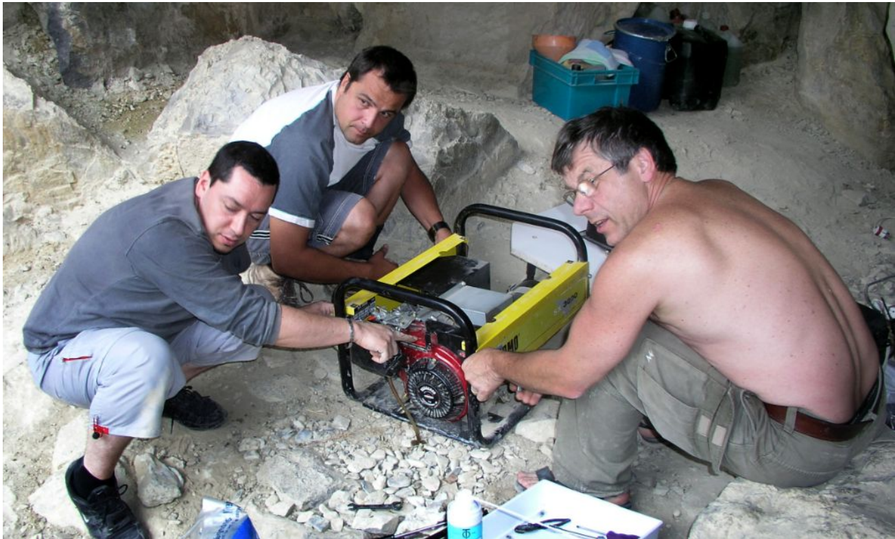
Illustration 21 – Réparation du groupe électrogène lors du pompage de la grotte des Chamois, Alpes-de-Hte-Prov. (28-6-2008).
