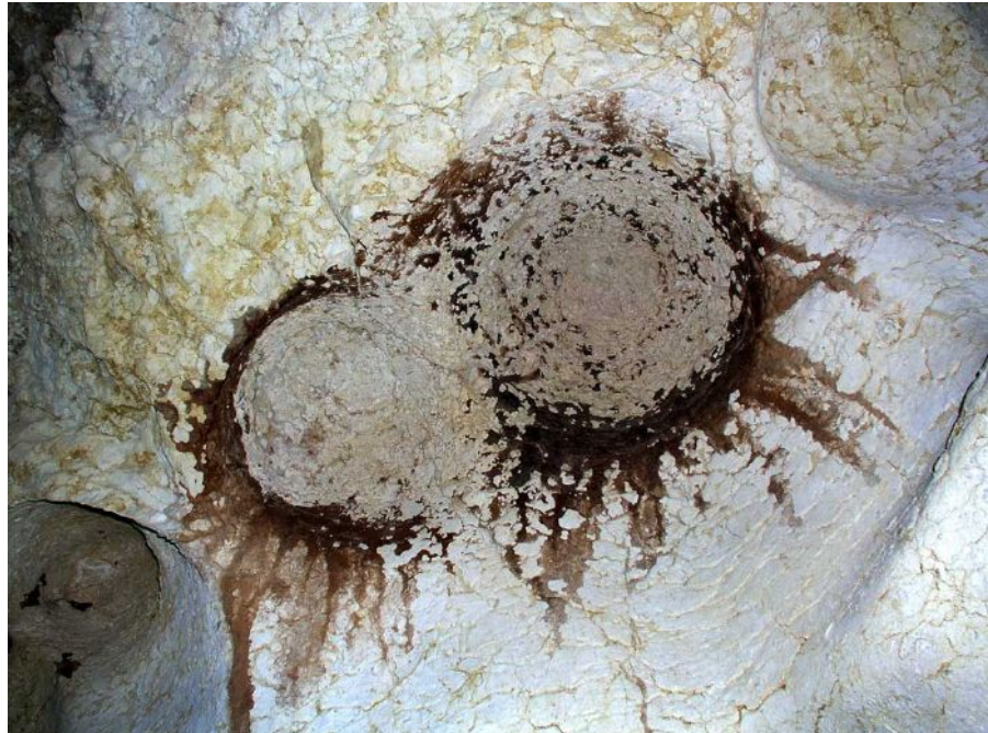
Figure 8. Coupoles de plafond anciennement occupées par les chauves-souris.
