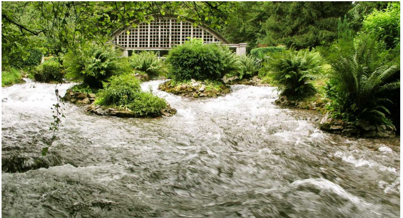
Figure 35. La station de captage de l'œil du Nééz à Rébénacq.
