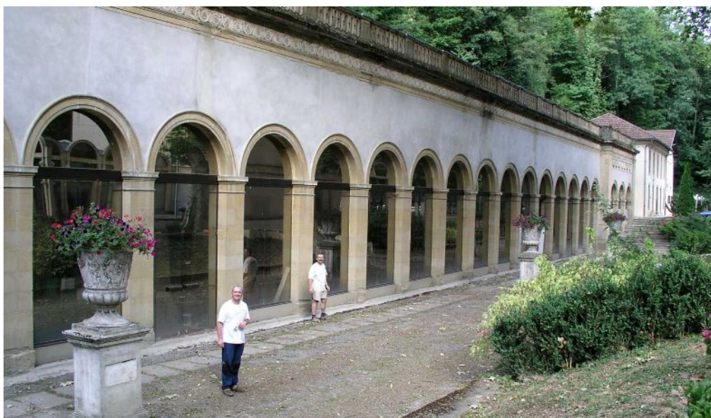
Figure 8. Le bâtiment classé des thermes Fraxine à Ussat-les-Bains.
