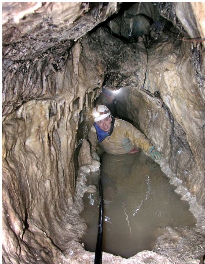
Illustration 23 – Installation des lignes et tuyaux dans la grotte des Chamois, Alpes-de-Haute-Provence (28-6-2008).
