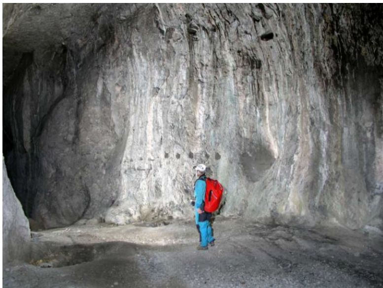
Figure 32. Trous de poutres dans le tunnel des Églises.
