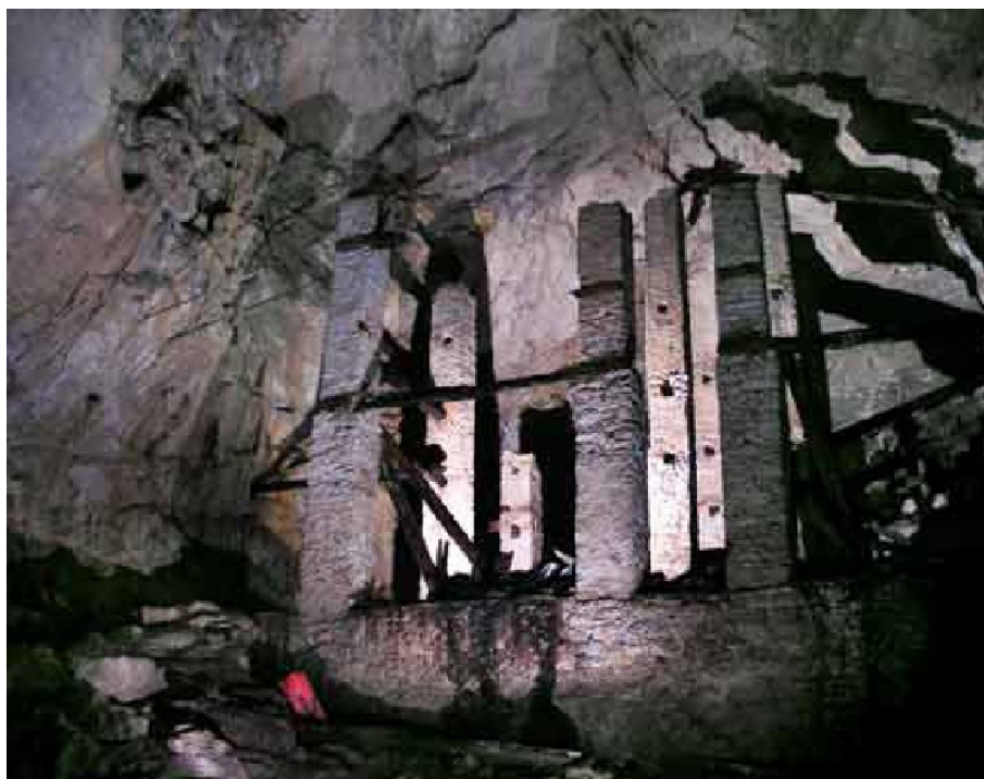
Figure 2. Piliers et poutres des planchers de la partie terminale du bâtiment souterrain.
