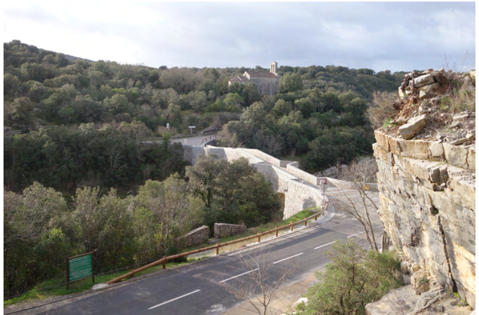
Figure 1. Le pont de Saint-Étienne-d'Issensac.
