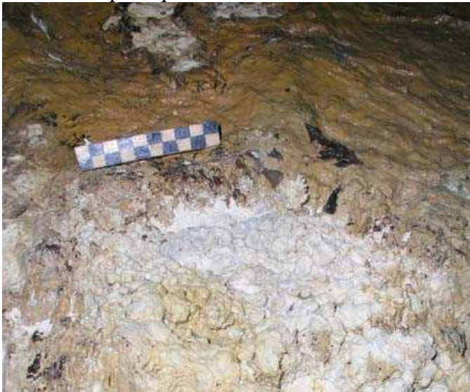
Figure 4 : Concrétions recouvertes par un film bactérien, puis corrodées par des suintement venant de la fissure.
