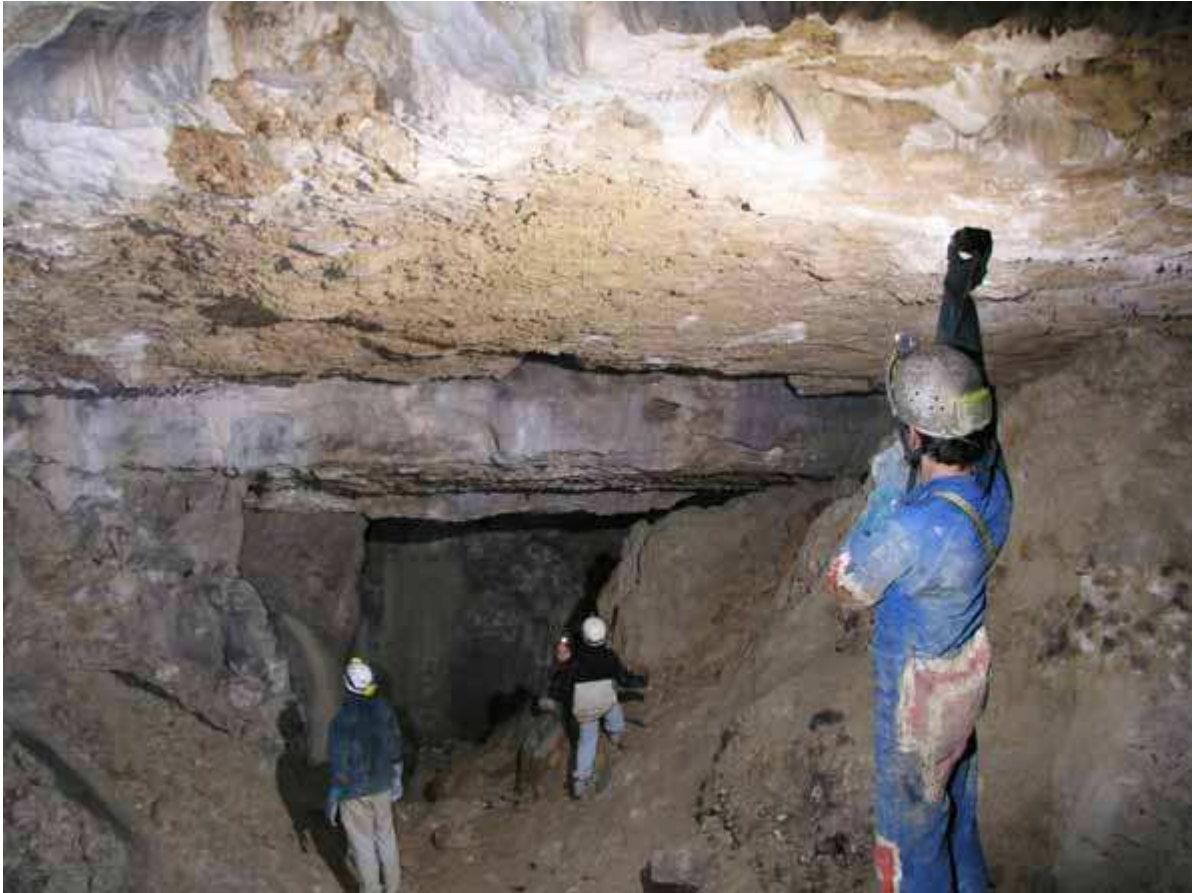
Section typique de galerie : en haut la dalle calcaire, en bas le conglomérat marneux raviné.
